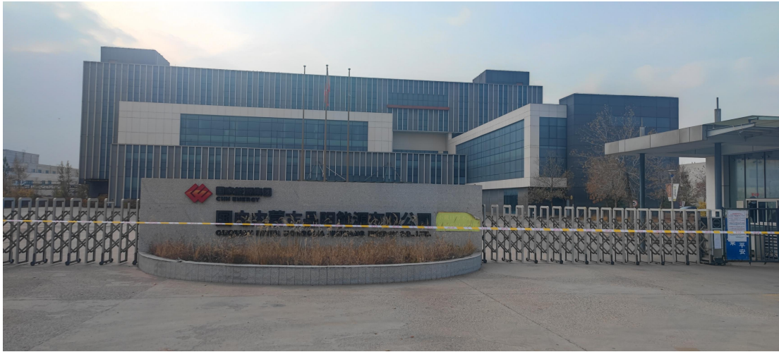
照片三：国电内蒙古晶阳能源有限公司
